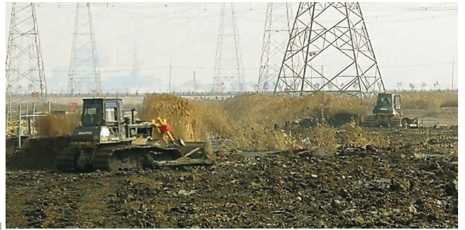
连日来,徐圩投资公司按照集团“1500 亩置换土地”项目开发要求,出动挖掘机 4 台、推土机 3 台,采用柴油机发电抽水等措施,新建围墙划分区域标志,对地块池塘进行破堆、整平,全面做好仓储物流、复垦地块前期准备工作。(刘永)
